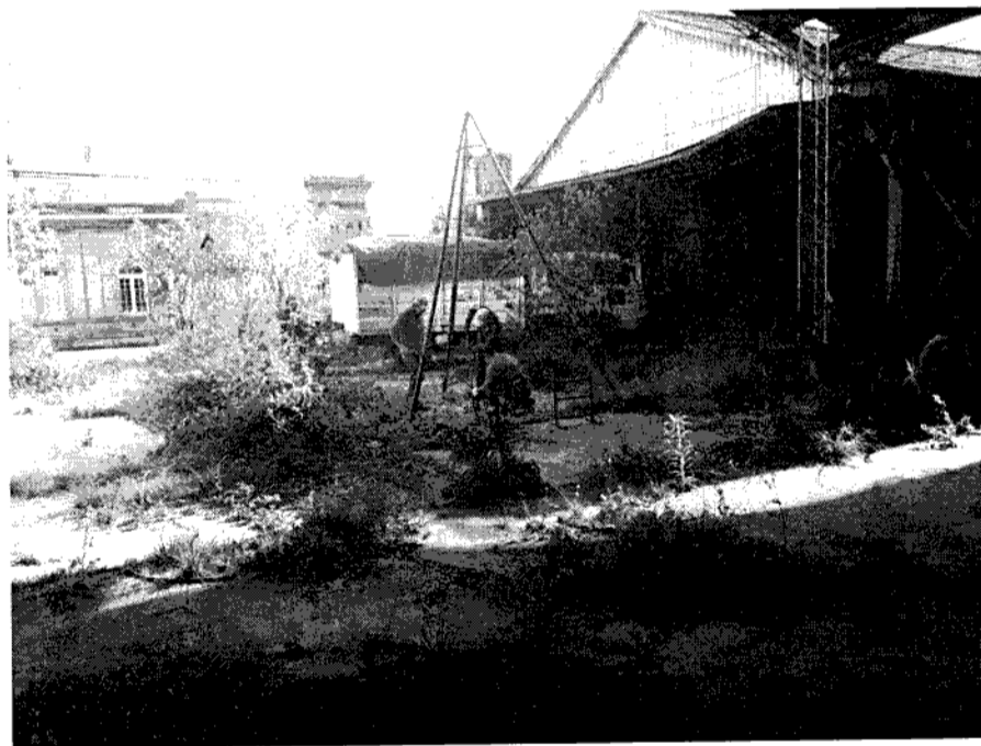
Trabajos de Estudio de Suelos realizado por Equipo Técnico de la Dirección Provincial de Vialidad. Predio ex SIES, calle Castellanos y Güemes, Santa Fe, Capital. Octubre 2022.
